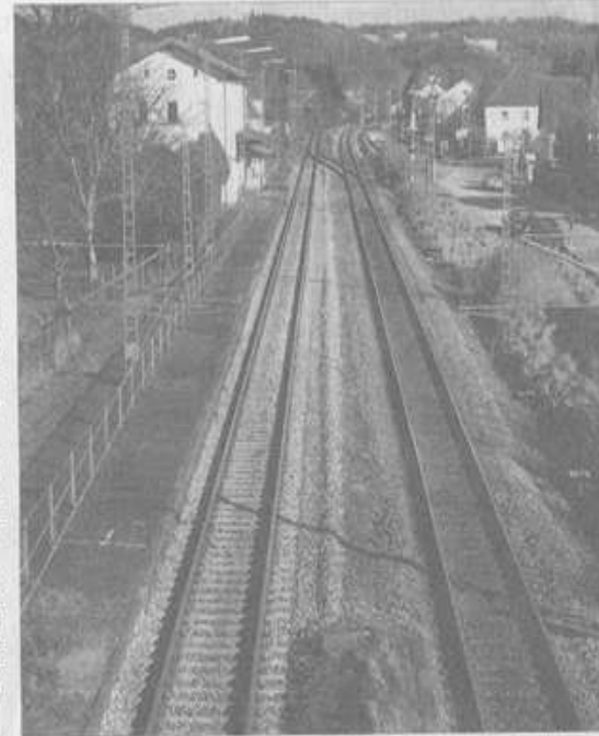
So sieht die Situation gegenwärtig aus. Lärmschutzwände links und rechts der Schienen würden den Ort wie durch eine Mauer teilen.
